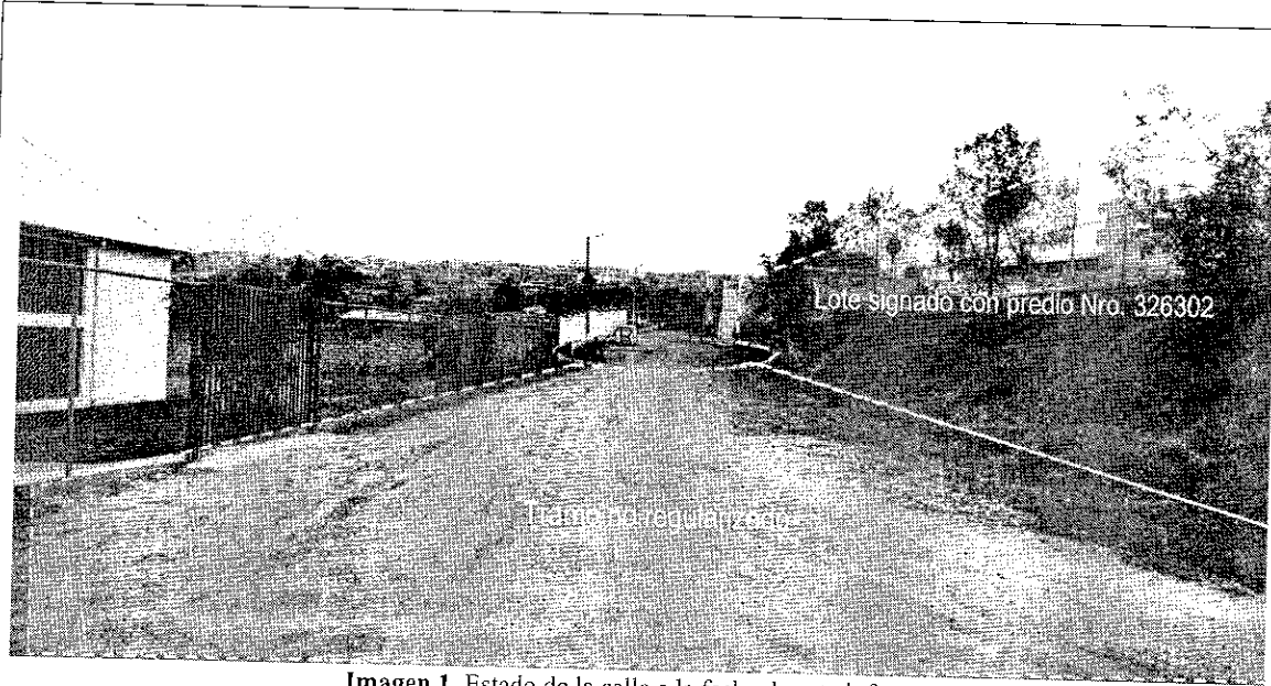
Imagen 1. Estado de la calle a la fecha de este informe
