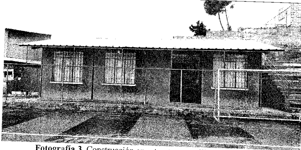
Fotografía 3. Construcción en estructura metálica (Sede Social).
